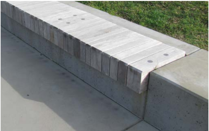
Timber seating edge
